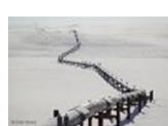
ท่อส่งน้ำมัน
